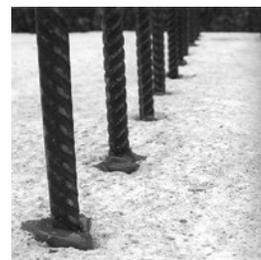
Устройство анкерных выпусков при реконструкции, усилении, ошибках при строительстве и для устройства закладных деталей.
