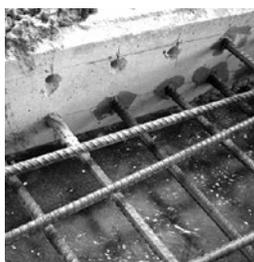
Устройство анкерных выпусков, при реконструкции, усилении конструкций, ошибках проектировании.
