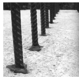
Устройство анкерных выпусков при реконструкции, усиливании, ошибках при строительстве и для устройства закладных деталей.
