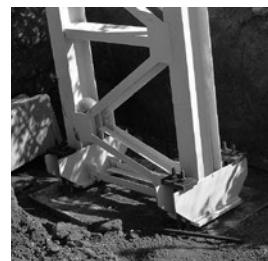
Устройство фундаментных болтов для металлических конструкций.
