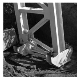
Устройство фундаментных болтов для металлических конструкций.
